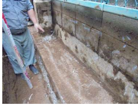
隣接宅地越境根の除根施工中
