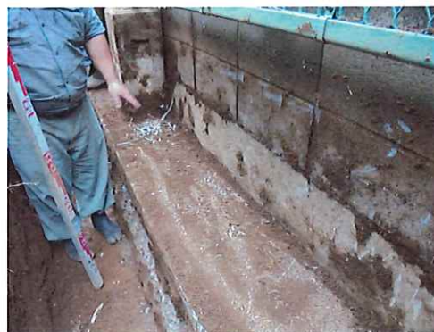
隣接宅地越境根の除根施工中
