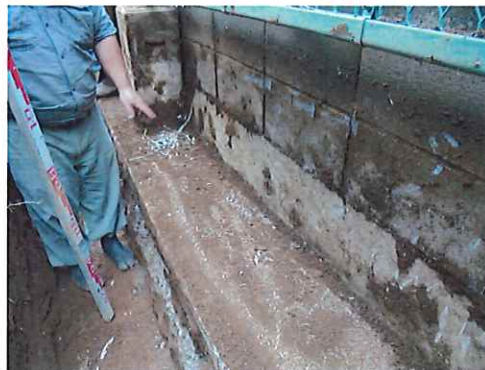
隣接宅地越境根の除根施工中
